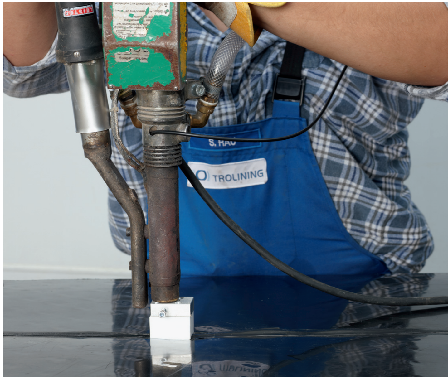
Die Verschweißung der PE-HD Betonschutzplatten erfolgt gemäß den DVS-Richtlinien und wird von zertifiziertem Personal ausgeführt.
