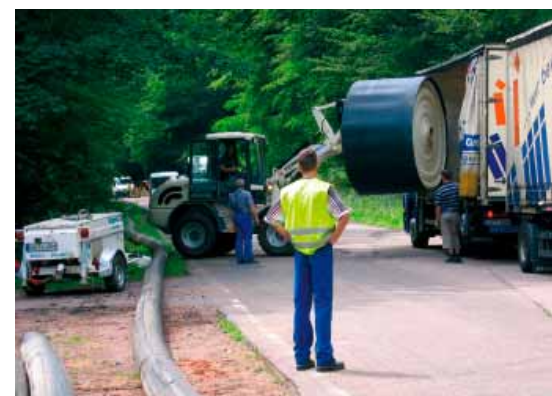
Entladen der Noppenschlauchcoils
