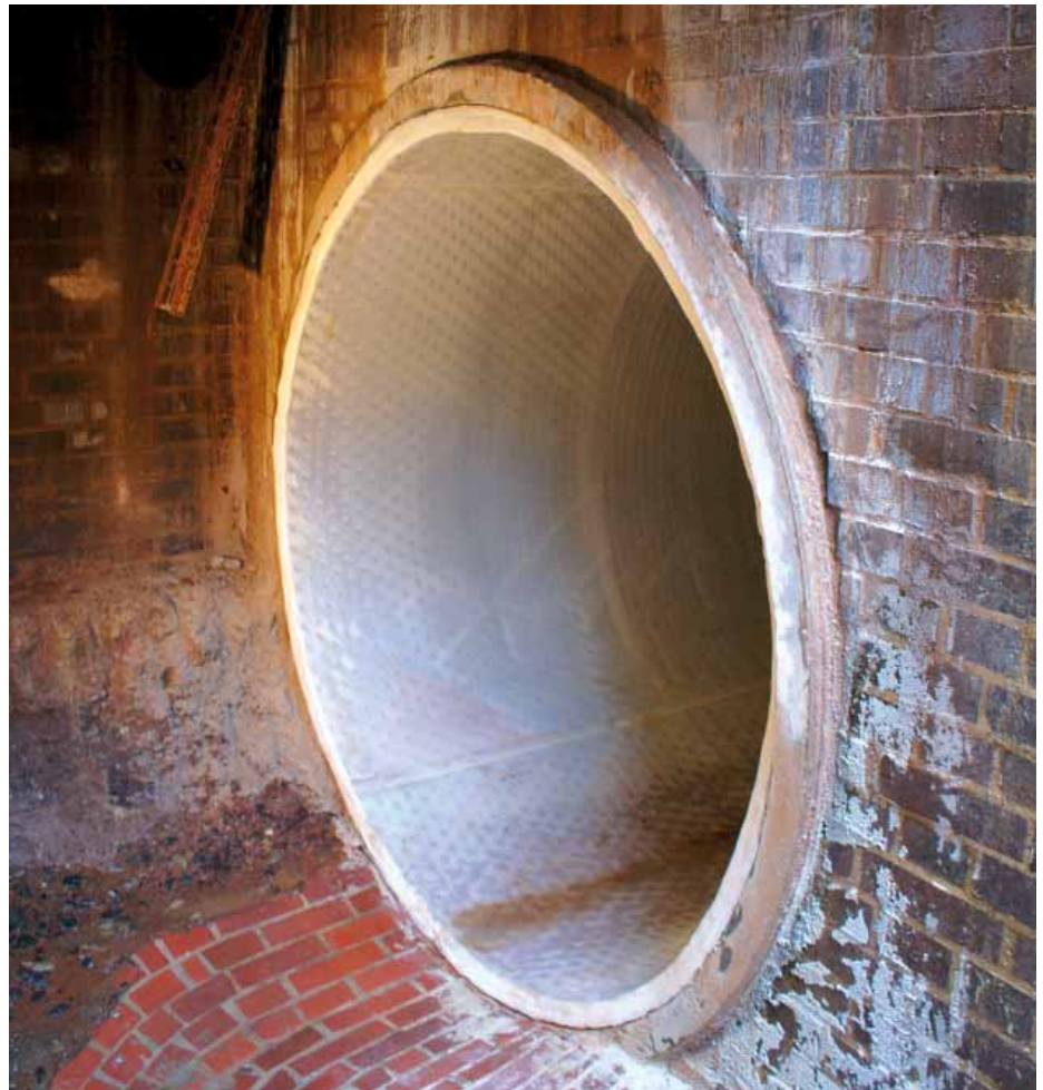
Bündig rückgeschnittenes System im Schacht
