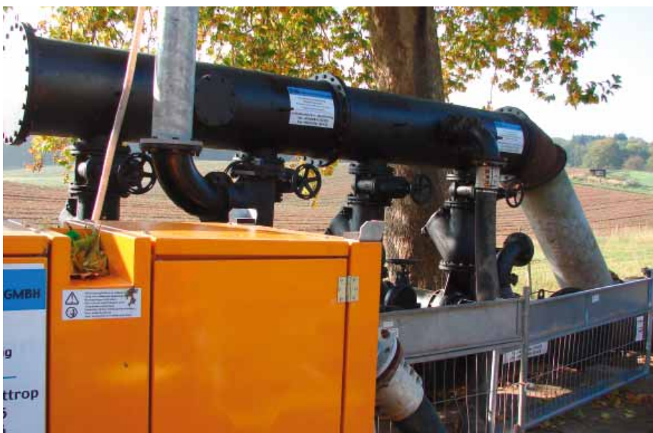
Pumpenanlage und Stahlröhre zur Abwasserleitung im Heimlinger Tal
